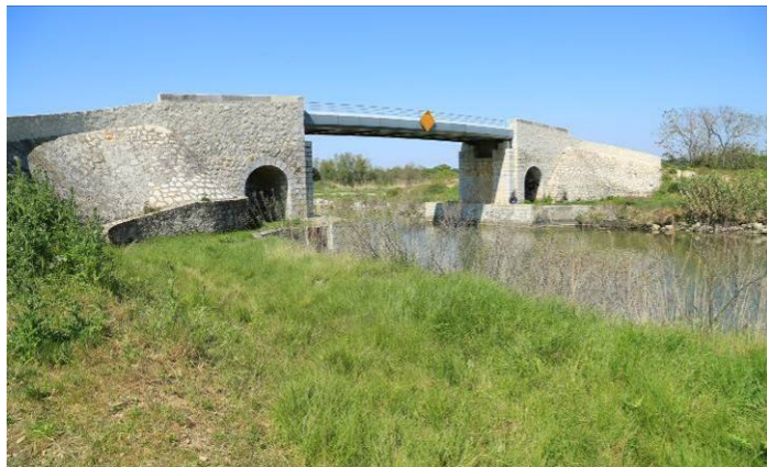
Station d'aristoloche du pont d'Espeyran
